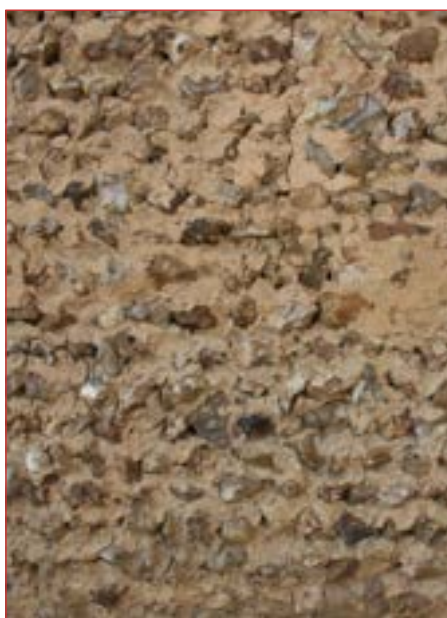
Maçonnerie de silex
