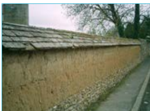
Mur en terre crue, soubassement silex. Broué.
