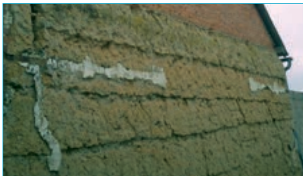
Mur en bauge. Broué.
