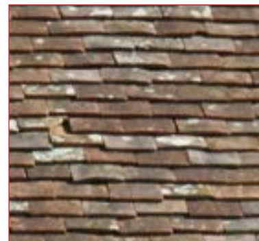
Tuiles de terre cuite, petit moule, rouge brun non uniforme.
