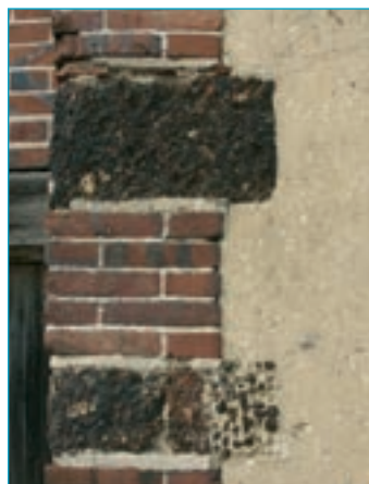
Maçonnerie en pierre de grison et brique.
