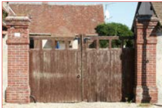
Portail avec piliers en brique. Tremblay-les-Villages
