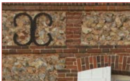
Maçonnerie de brique et silex.
