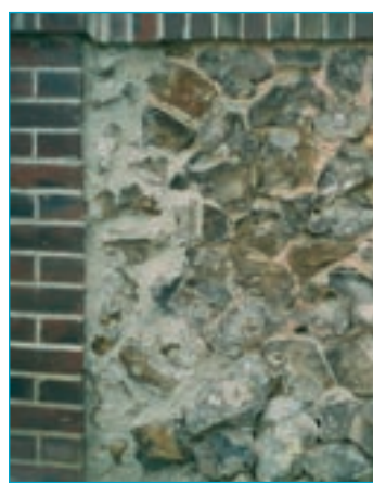
Mur en silex et chaîne en brique.
