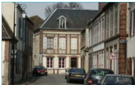
Maisons en maçonnerie de moellons enduite et brique appareillée. Brezolos.
