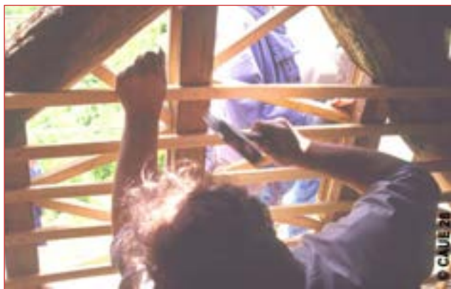
Chantier de restauration d'un mur en torchis. Au dessus, réparation de la structure secondaire à éclisses et barreaudage. En dessous, application du torchis sur la structure secondaire avant de remplir les "vides" intersticiels.
