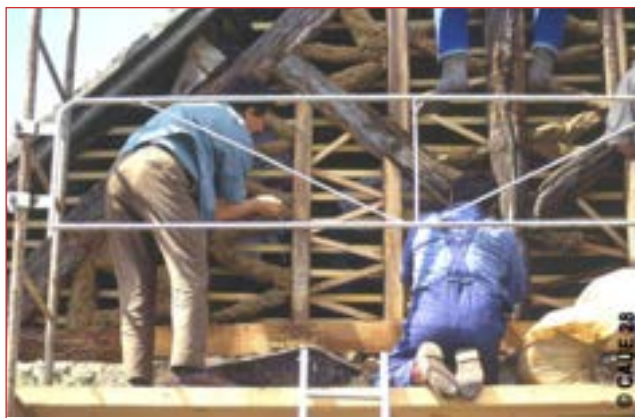
Chantier de restauration d'un mur en torchis. Au dessus, réparation de la structure secondaire à éclisses et barreaudage. En dessous, application du torchis sur la structure secondaire avant de remplir les "vides" intersticiels.
